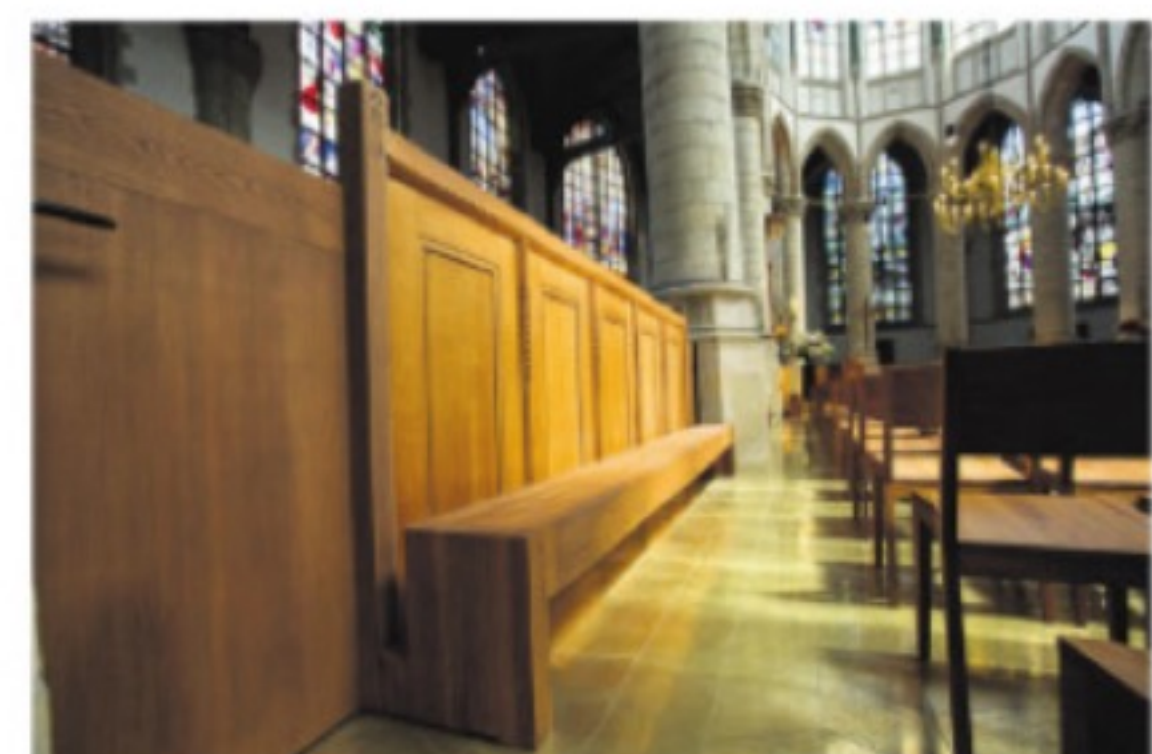
De schotten die het koor van de rest van de kerk afschermen zijn demontabel gemaakt.
