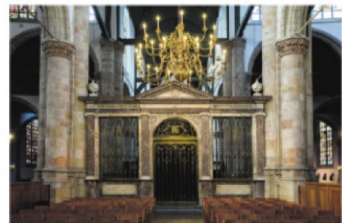
Het koorhek. De fundering onder het koor was zo slecht dat de pilaren verzakten.
